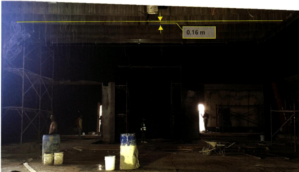
Figura 38. Una adaptación con cambio de perspectiva de una de las imágenes de la renovación de 2015. Se han añadido una línea amarilla, que es aproximadamente paralela al borde inferior de la viga cerca de su extremo, y una línea azul, que es paralela al borde inferior de la viga cerca de su punto medio. Mediante el análisis de imágenes y perspectivas de las fotografías tomadas, se determinó que las deflexiones estimadas oscilaban entre 0.16 m y 0.3 m, dependiendo de la imagen y la técnica utilizada.
