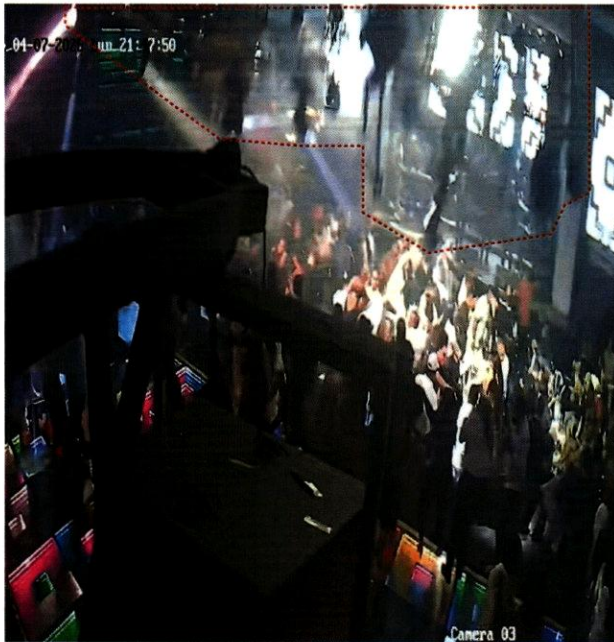
Figura 54. Imagen fija del CH3 - G277 que muestra el inicio del colapso general del techo (delimitado por la línea discontinua roja).
