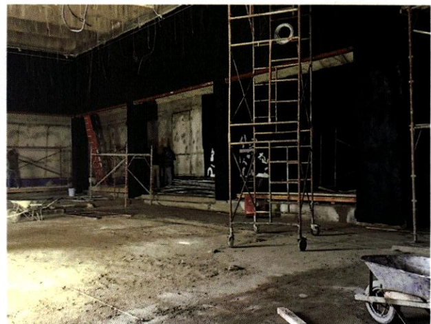
Figura 37. Imagen de la renovación de 2015 que muestra el lado este del club con vigas postensadas a la vista.
