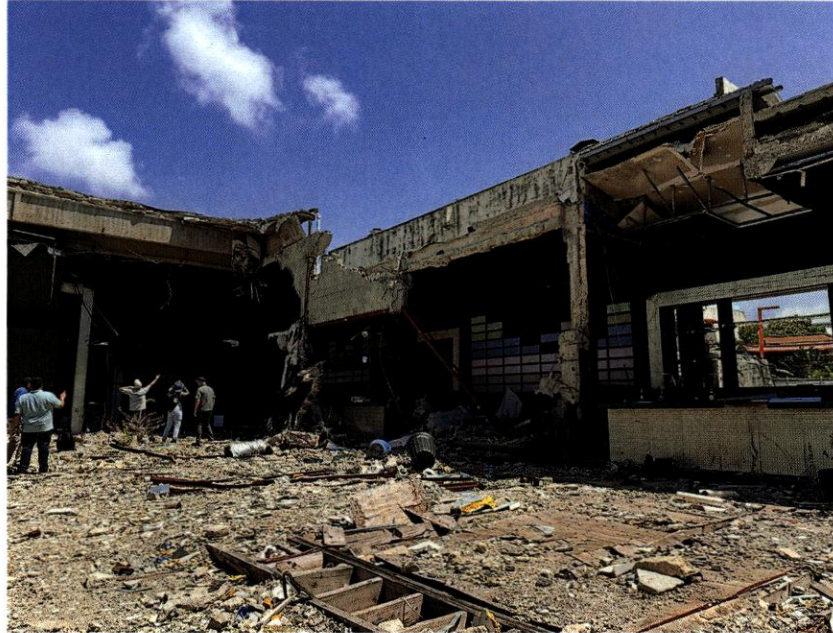
Figura 5. Estado del sitio Jet Set Night Club durante la visita del 10 de abril de 2026.
