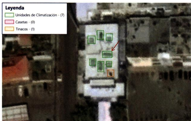
Figura 60. Imagen aérea del techo de Jet Set, de octubre de 2014, proporcionada por Google Earth. Anotaciones realizadas según se indica en la leyenda.
