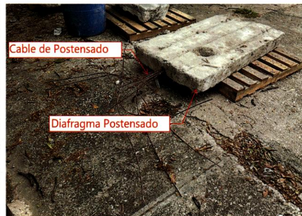
Figura 9. Fotografía tomada por WJE del diafragma de concreto postensado identificado en el patio de almacenamiento.
