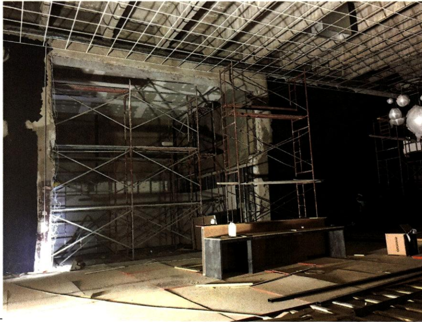
Figura 2. Fotografía de la pared oeste del club Jet Set tomada en 2015 durante las remodelaciones. La estructura de soporte del techo falso es visible bajo las vigas del techo.
