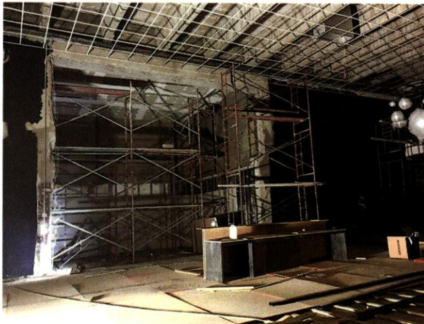
Figura 34. Imagen de la renovación de 2015 que muestra el escenario, la parrilla del techo y las vigas de concreto postensadas expuestas.
