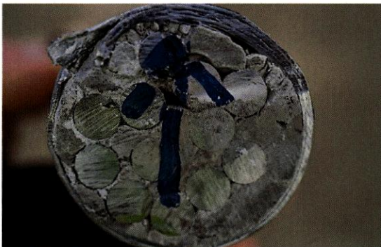
Figura 99. Sección transversal de un ducto corrugado que expone la lechada y doce alambres de postensado. Muestra extraída del espécimen de viga F-B-BM-1
