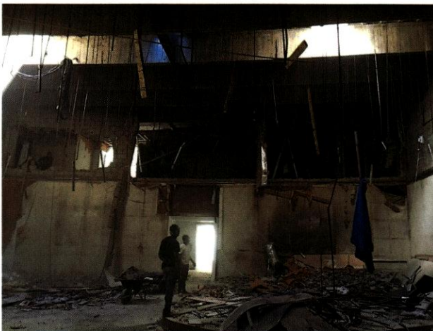
Figura 36. Imagen de la renovación de 2015 en la que se aprecia el extremo sur del club con vigas postensadas a la vista.
