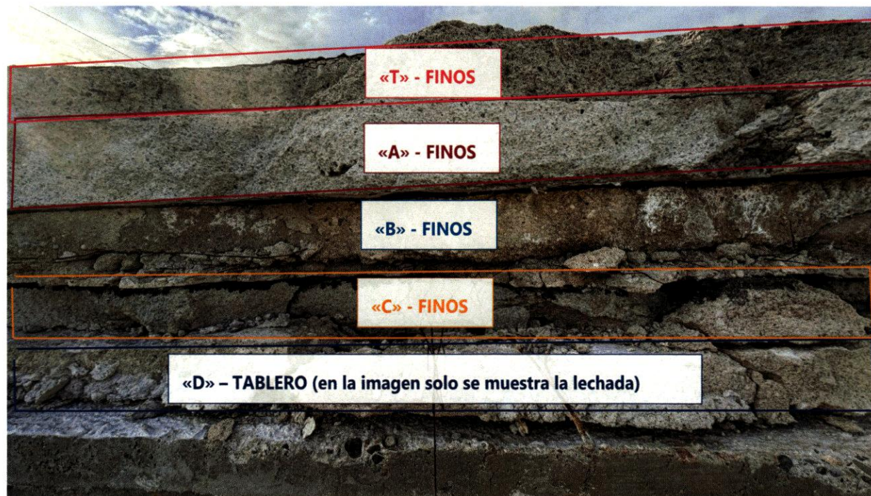
Figura 125. Montaje típico del techo sobre la Viga Norte. Fotografía tomada a unos 7.5 metros del extremo oeste de la Viga Norte.
