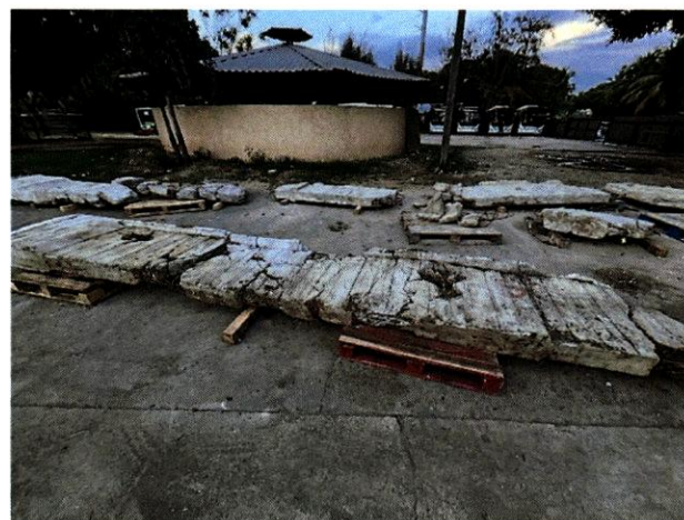
Figura 75. Vista del espécimen de viga F-A-BM-21 en el Sitio F.
